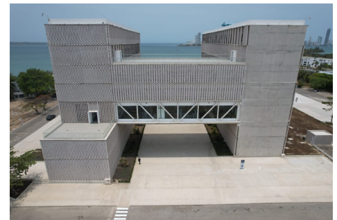
Una vista frontal a la estructura del edificio Gran Almirante Padilla, en la que se observa la “U interna”.
